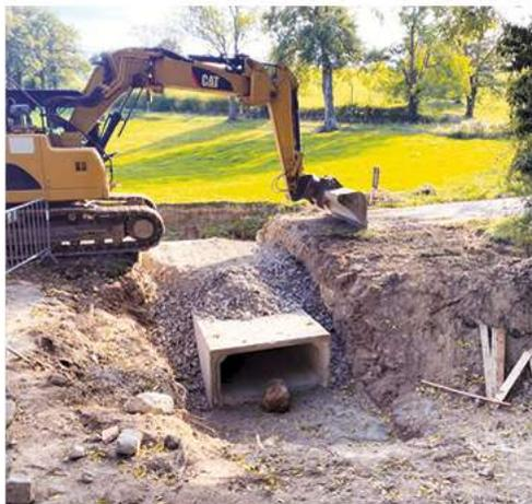
Comme annoncé dans la dernière gazette, les travaux de réfection du Pont du Ris de Queurdre se sont déroulés en octobre, sous le contrôle de la police de l'eau. La démolition totale de l'ancien ouvrage d'art a été suivie par la construction d'un nouveau pont permettant aujourd'hui de franchir le ruisseau en toute sécurité.
